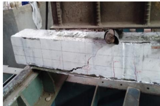
Gambar 17 Retak pada sebagian bentang [2]
