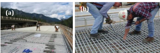
Gambar 3 (a) Penerapan FRP reinforcing bars pada lantai jembatan Salmon River Bridge, British Columbia; dan (b) pemakaian GFRP dan CFRP reinforcement pada lantai Wotton Bridge.
